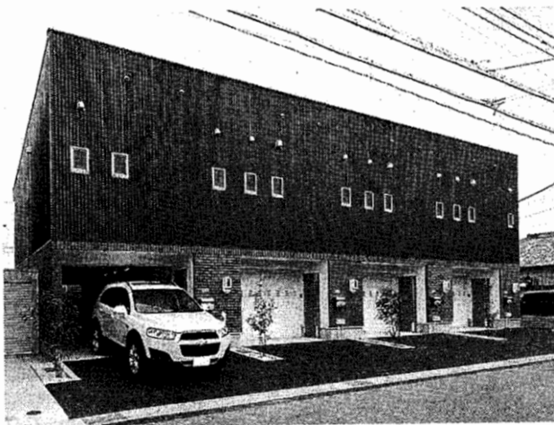
賃貸ガレージハウスの施工例
